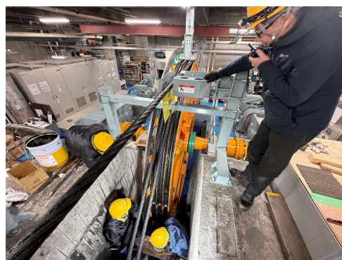
黒部ケーブルカー原動滑車ゴムブロック交換
