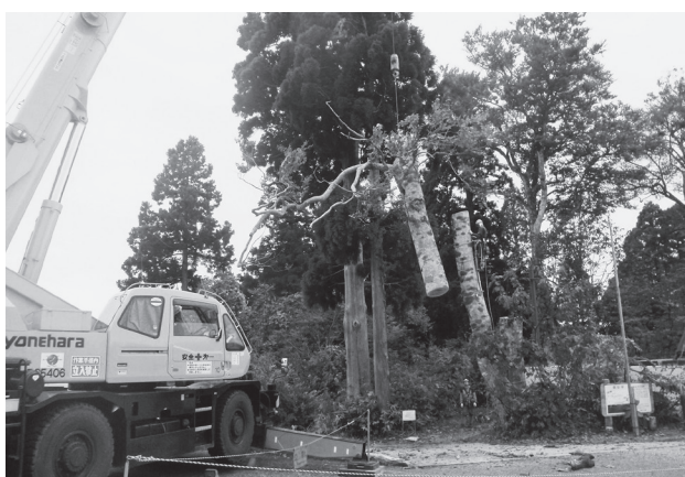
図3, 伐採した幹を撤去する作業
