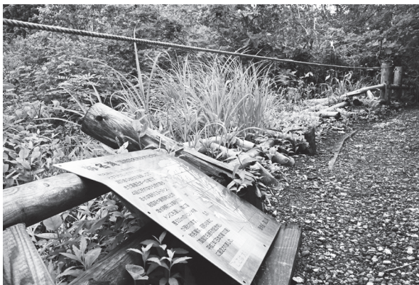
図11, 移動圧により破壊された柵と説明板
