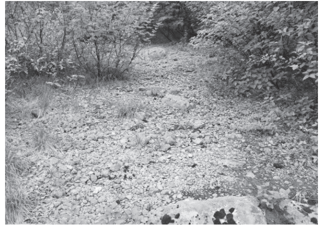
写真－8. ジープ道の路面（mida70Eにて）。 碎石が堅く敷き詰められている。
