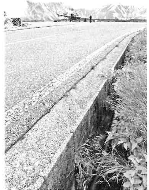
図5. 国見第一駐車場（ヘリポート）に近接する側溝
