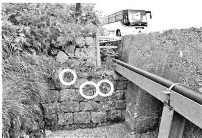
図6. 国見第一駐車場上端付近の山側にある排水柵No.45
