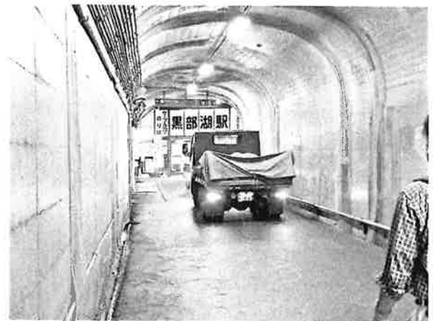
図7. 資材を積載して黒部ダムから黒部湖駅前を経て左岸の船着き場へ向かうトラック
