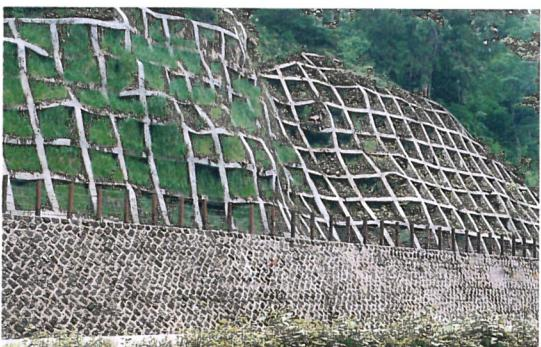
写真I-① 桑谷のフリーフレーム工法 (平成9年6月)
