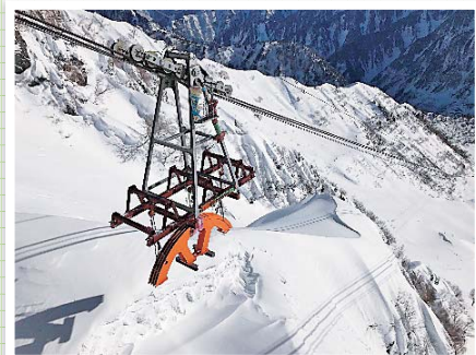
立山ロープウェイの搬器を取り外して資材を搬入
