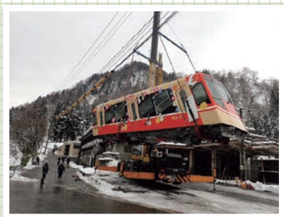
台枠更新後の客車を、立山駅へ搬入
